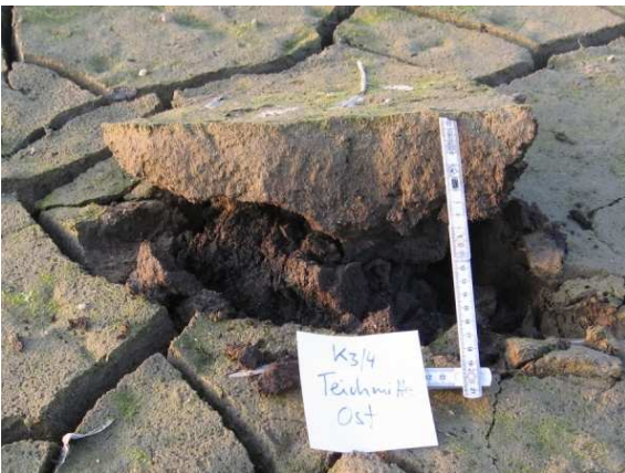
Foto 14: KA2007 K3/4 Mischwasser
