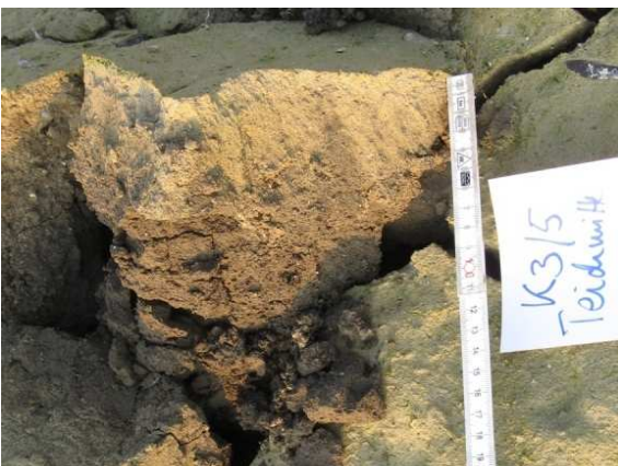
Foto 11: RB K3/5 Mischwasser
