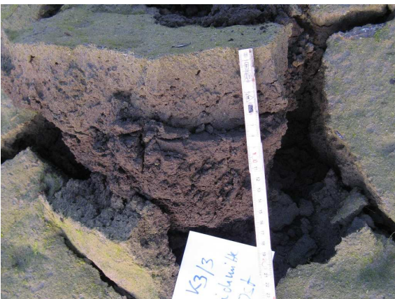
Foto 15: KA K3/3 Mischwasser,
