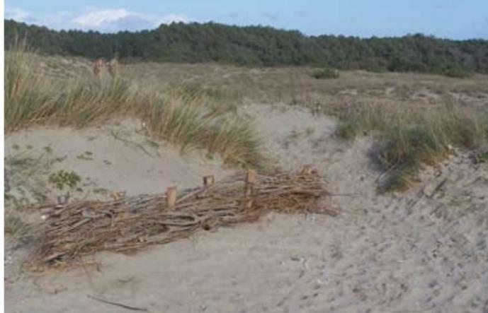
Fig. 89. Fascinata posta lato mare per interrompere la fruizione di un sentiero in uso prima dei lavori, ricostituendo un rilievo dunale.
