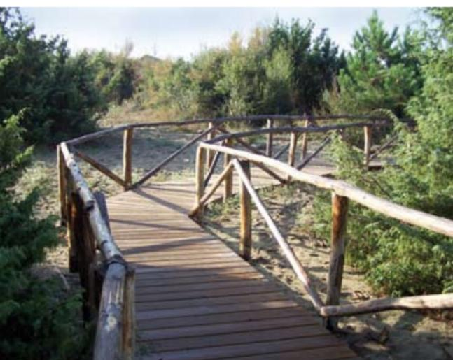
Fig. 98. Esempio di attraversamento in legno con passerella e staccionata in ambienti dunali aperti.
