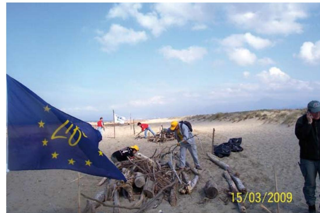
Fig. 163. Volontari che realizzano fascinate artigianali per la ricostruzione delle dune.
