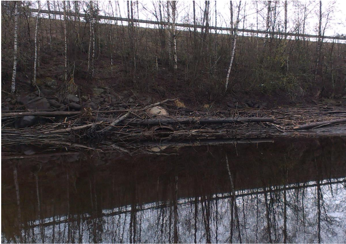
Figur 3. Rør gjennom E6 fyllingen sett fra Svartelvdeltaet.
