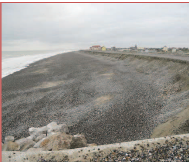
Erosion de la digue protectrice des Bas-champs à Cayeux-sur-Mer après une tempête. © SMBS-GLP
