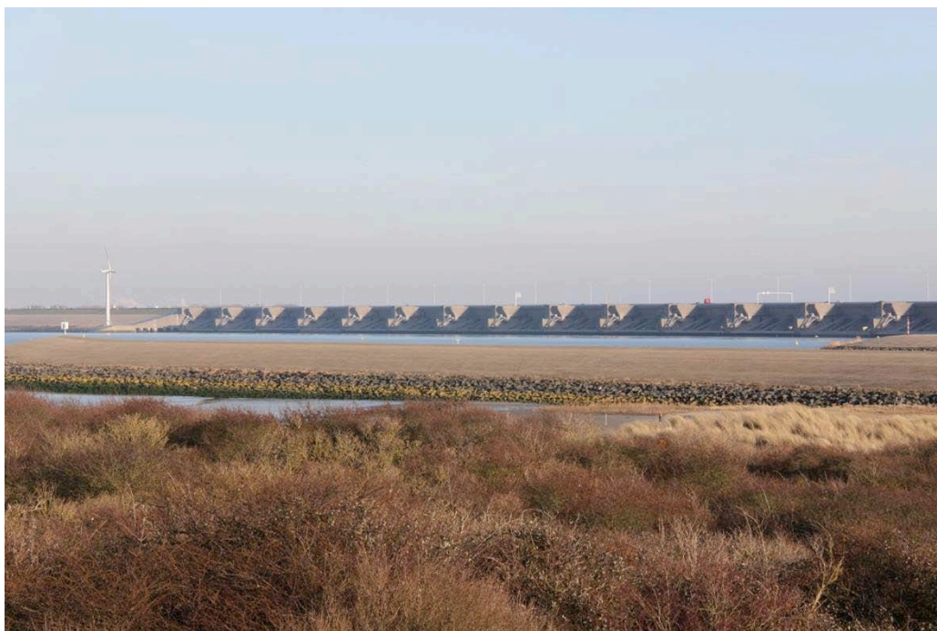
Figuur 4.12 Haringvlietdam met de daarin aangebrachte spuisluizen (foto: Diederik van Bentum)
