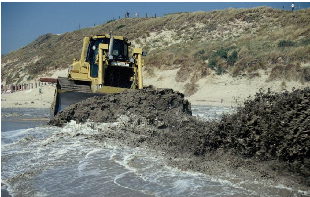
Foto 6.3. Werkzaamheden strandsuppletie. (Foto Rijkswatestaat)
