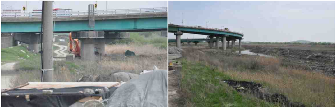
장항습지 내 공사 현황
