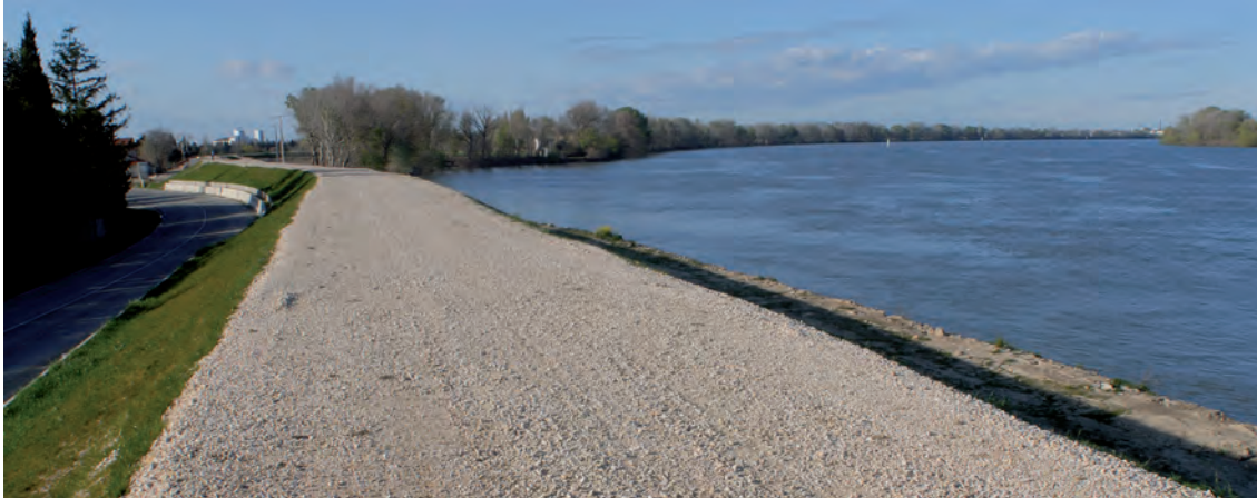
Digue de Rougnouse - photo Jean Roché
