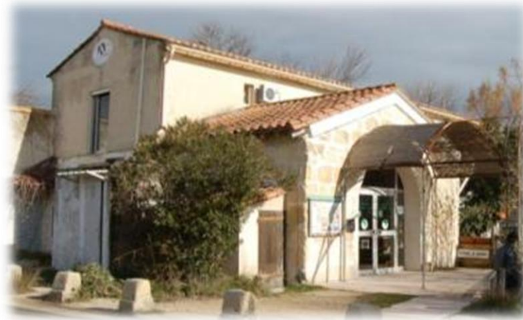
Photo 35: Centre d'accueil de la Capelière
