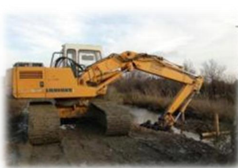
Photo 7 : Travaux sur la Réserve
