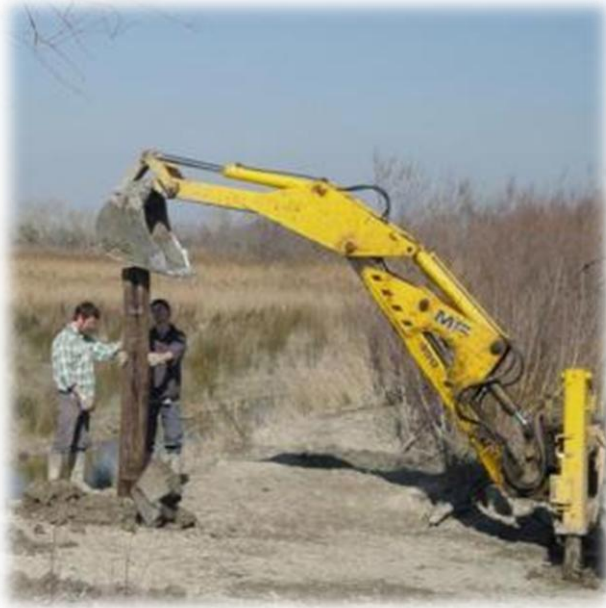
Photo 12: Travaux sur la Réserve
