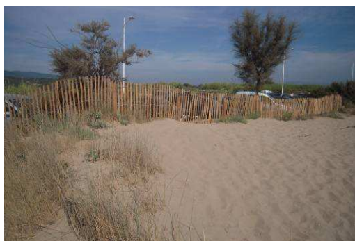
Renouvellement de ganivelles
