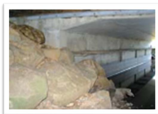
Figure n° 152 : Encorbellement (passage à sec sous un pont)
