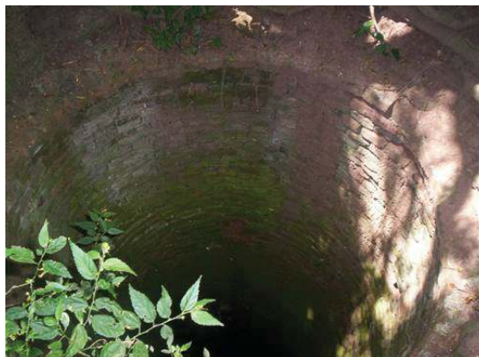
Pozo de agua revestido en ladrillo.
