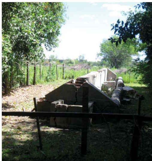
Bebedero, al fondo se observa la línea de talas que actualmente delimitarían los antiguos potreros.
