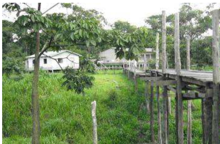
Figura 3.30 Passarela na comunidade de Antonina. Foto: Tharcísio Cruz.
