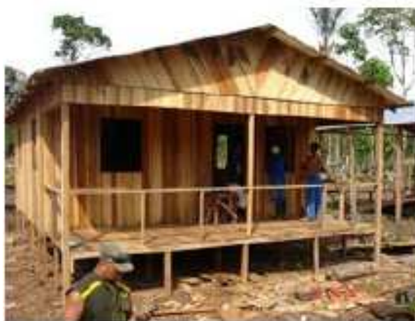
Figura 3.32 Modelo da “casa nova” viabilizada pelo Incra e Ibama por meio de crédito habitação. Comunidade Igarapé do Branco. Foto: Raphael Leduc.
