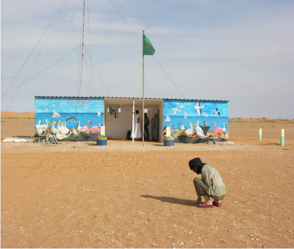
Fig. 1. Poste de Chami, entrée et poste de contrôle du PNBA. Nov-05.
