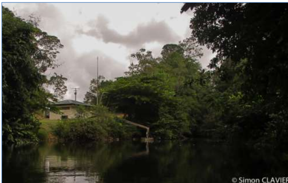
Figure 31 : Station de pompage d'eau brute sur la crique Yiyi (S. Clavier / HYDRECO)
