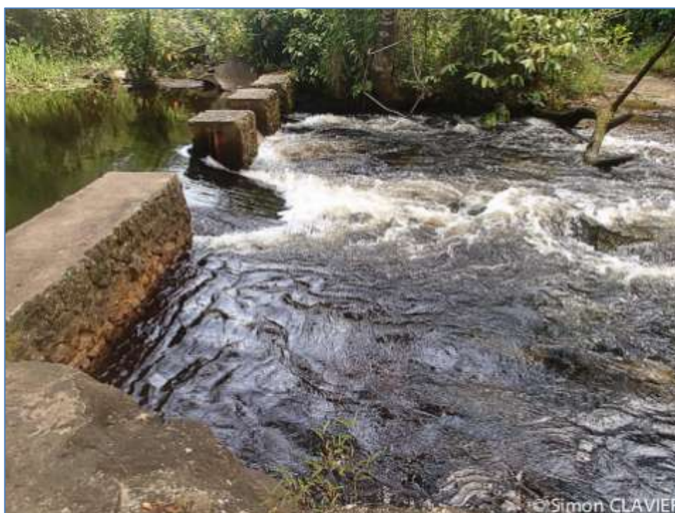
Figure 34 : Le seuil de la crique Canceler a été installé en 2006 pour compenser un seuil naturel excavé lors de la création de la RN1 (S. Clavier / HYDRECO)
