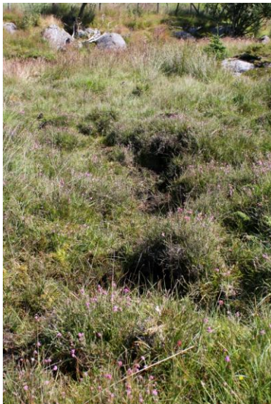
Figur 2.4: Spor etter grøfting nordaust. Juli 2012. Foto: © Torborg Berge
