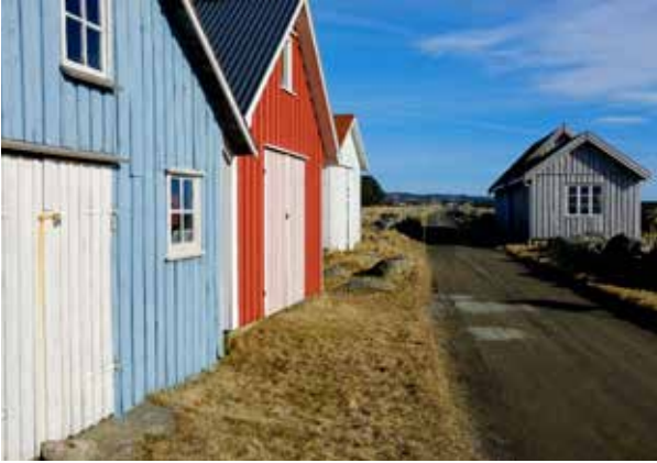
Sjøboder i Verevågen. Foto: Pål Klevan
