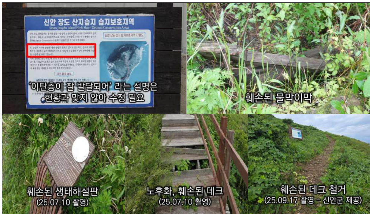
[그림 65] 신안 장도 산지습지 습지보호지역 이용시설 훼손 현황
