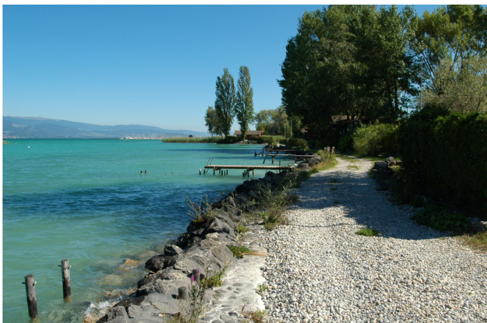
Figure 5.2 : Chemin d'accès, pontons et enrochements de protection contre l'érosion dans le secteur de résidences secondaires de Delley-Portalban Ouest
