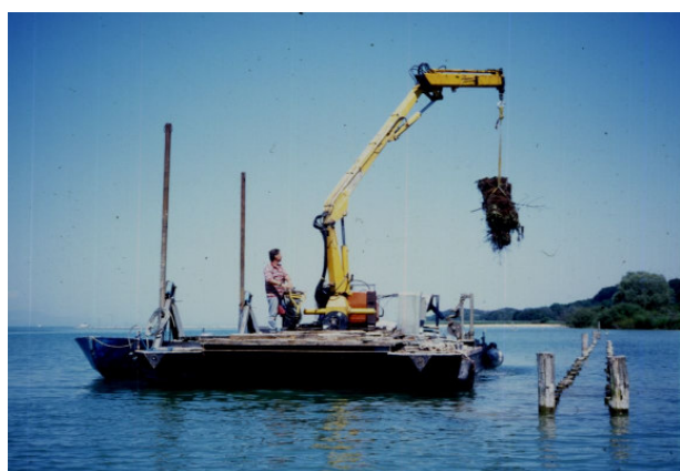
Figure 8.2.1b-c : Aménagement d'infrastructures de lutte contre l'érosion des surfaces marécageuses terrestres, tronçon-pilote de Cheseaux-Noréaz (VD). A gauche déchargement d'un récif artificiel. A droite pose d'une palissade à claire-voie
