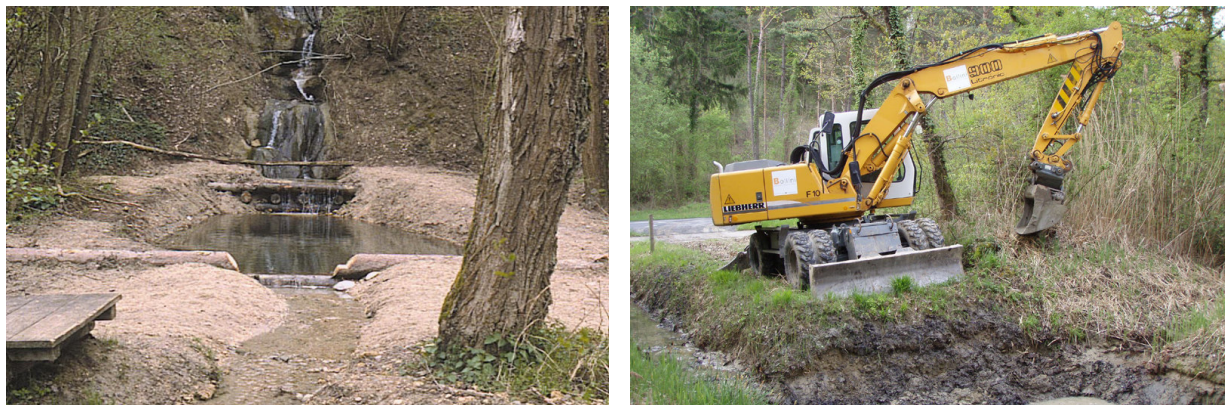
Figure 8.2.2b : Renaturation de cours d'eau. A gauche : dessableur aménagé dans la réserve naturelle de Cheyres sur territoire de la commune de Châbles (FR). A droite : curage du dessableur de Châble-Perron, commune de Cheseaux-Noréaz (VD)
