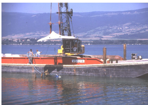
Figure 8.2.1b-c : Aménagement d'infrastructures de lutte contre l'érosion des surfaces marécageuses terrestres, tronçon-pilote de Cheseaux-Noréaz (VD). A gauche déchargement d'un récif artificiel. A droite pose d'une palissade à claire-voie
