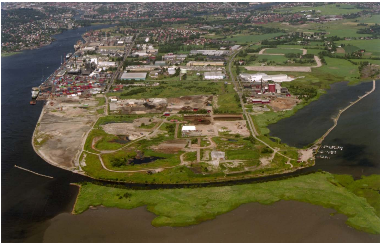
Figur 11. Utsyn nordover med industriområdet og havna. Ørakanalen i forgrunnen, fangarm til venstre ved innløpet til kanalen. Fredrikstad by i bakgrunnen. Foto: Gunnar Bjar, Fylkesmannen i Østfold
