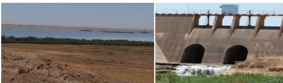
Photo 5: Vue partielle du barrage de Boughzoul et les galeries de vidange (Geosystem-consult 2011)
