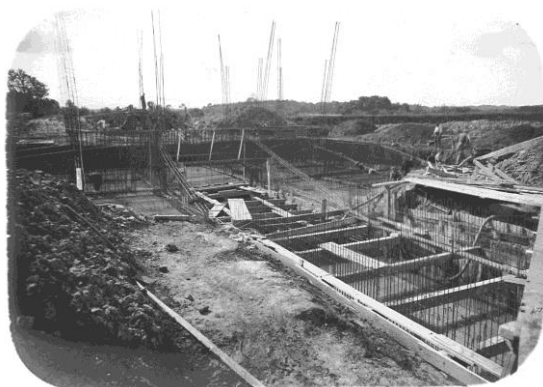
Construction du canal d'amenée de la station de pompage électrique (TOSI)
