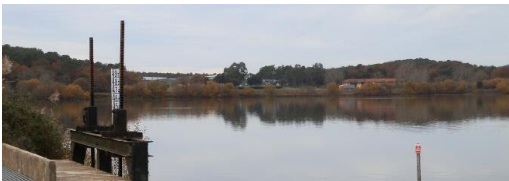
Vue sur l'usine Bonduelle (SOLEAL) depuis le pont noir de la RD71 côté Marais Central
