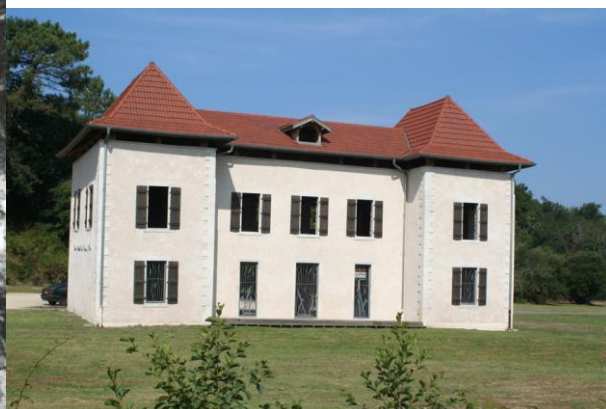
La Maison de l'ingénieur Lefebvre-Béziers restaurée
