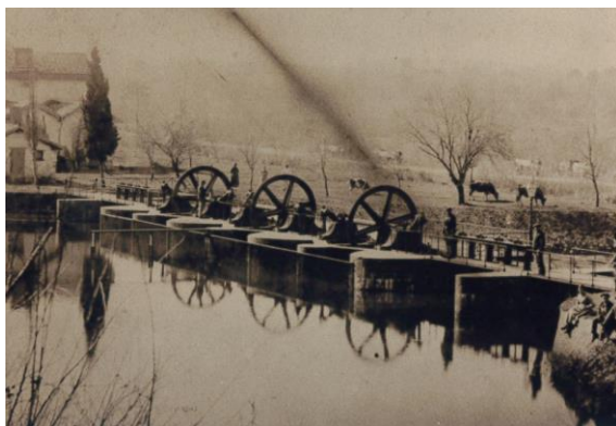
Le premier système de pompage : les pompes « Napoléon »
