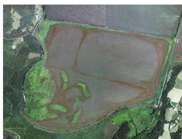
Marais Barrage à environ 1,30 m NGF (configuration « hiver »)
