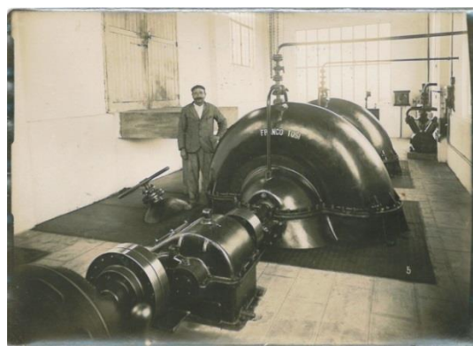
Le second système de pompage : les pompes électriques « TOSI »
