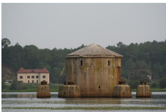
Maison Béziers et casemate
