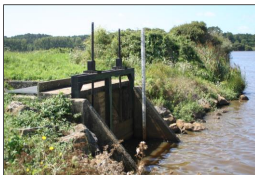
Ouvrage du « Pont Noir » reliant le casier Central au casier Barrage
