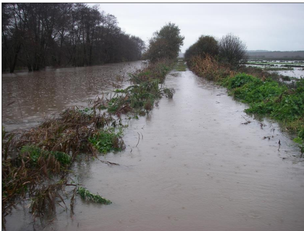
Cas de crue sur la digue Est avec submersion de la digue (décembre 2008)
