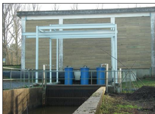
Station de pompage (Marais Barrage)
