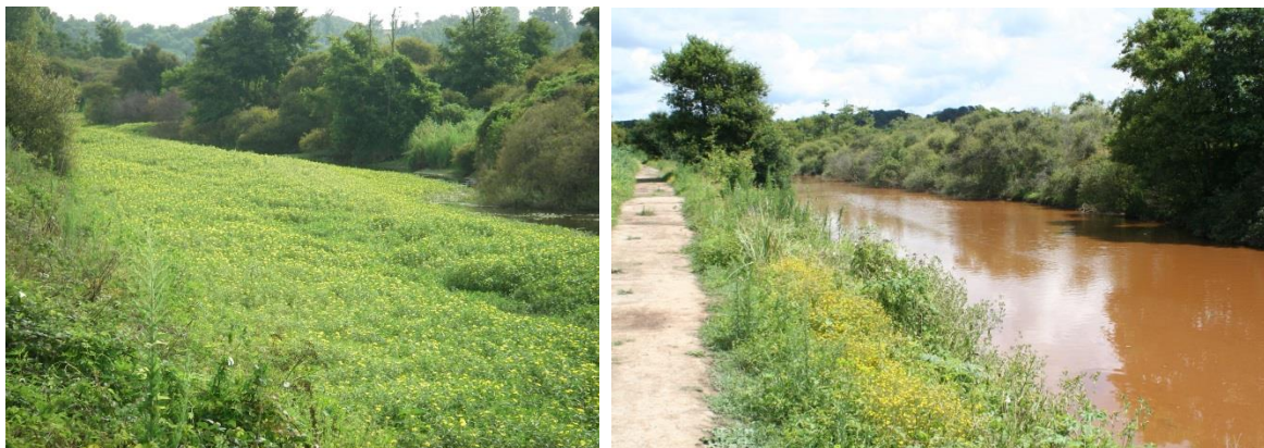
Canal Boudigau avant / après travaux – tranche1 - 2007
