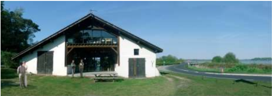
Arrière de la Maison Béziérs avant travaux
