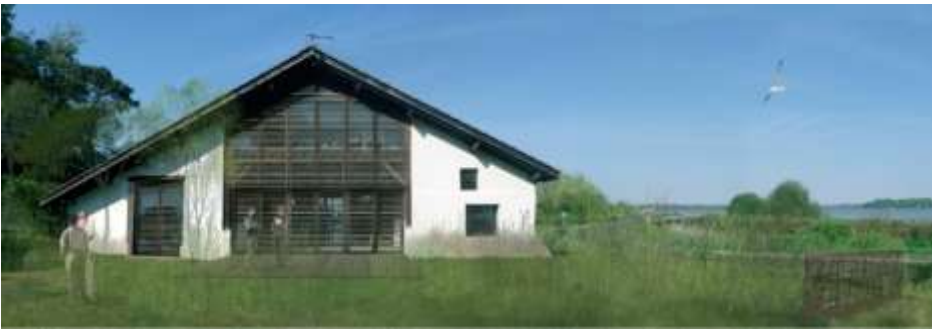
Arrière de la Maison Béziérs après travaux
