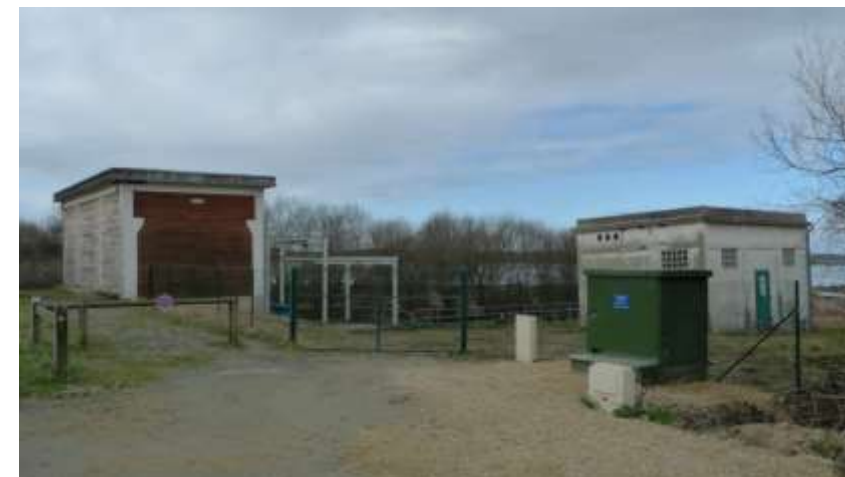
Station pompage avant travaux
