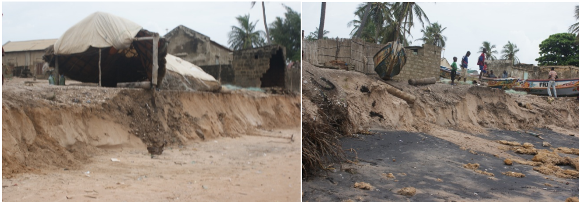
Photos : impact de l'érosion côtière sur le village de Ngallou suite aux houles du mois de février 2014.
