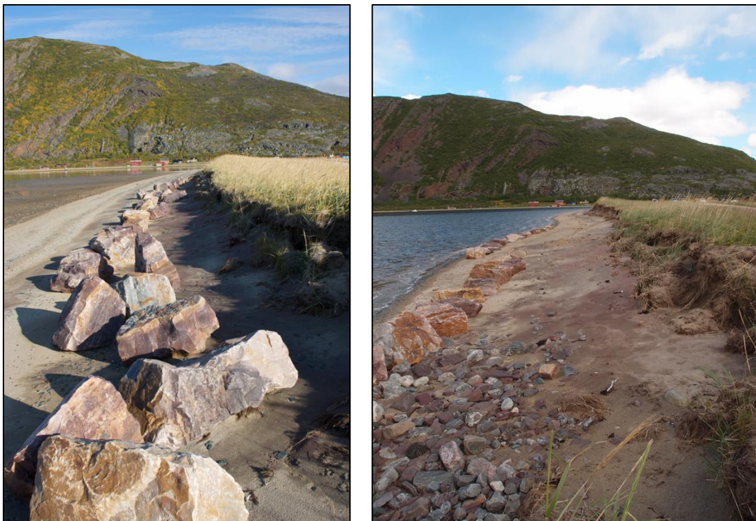
Bildene viser plasseringen av steinene i det erosjonsutsatte området på nordsiden av Høyholmen. Bildet til venstre er tatt i 2008 og det til høyre er tatt i 2015. Foto: J. Fløgstad og M. W. Sundfør
