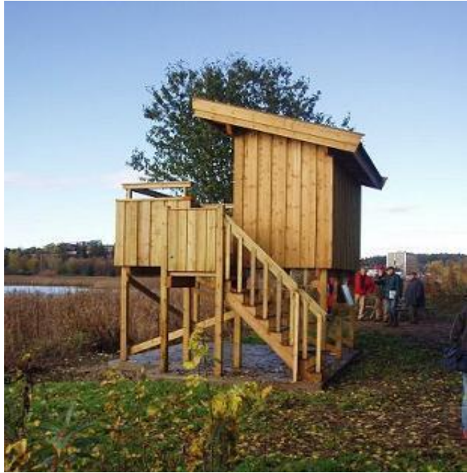
Figur 21. Presterødkilen er godt tilrettelagt for fuglekikking. Dette observasjonstårnet står nord i reservatet.
