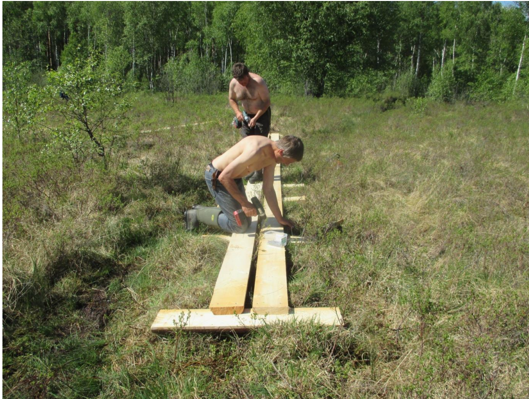
Fig 2. Uvdøler legger gangbaner.
