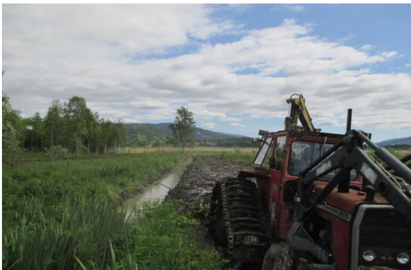
Fig 4. Fra graving av hovedkanalen. Massene fra kanalen ble jevnet ut og vegetasjonen ble raskt reetablert med stedegen vegetasjon.
