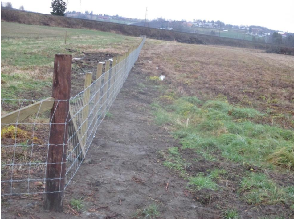
Figur 7. Solide hjørnestolper med skråstøtter, lange rettstrekk og god stramming gjør at gjerdet står godt mot snø og andre ytre påkjenninger. Topptråd mangler.
