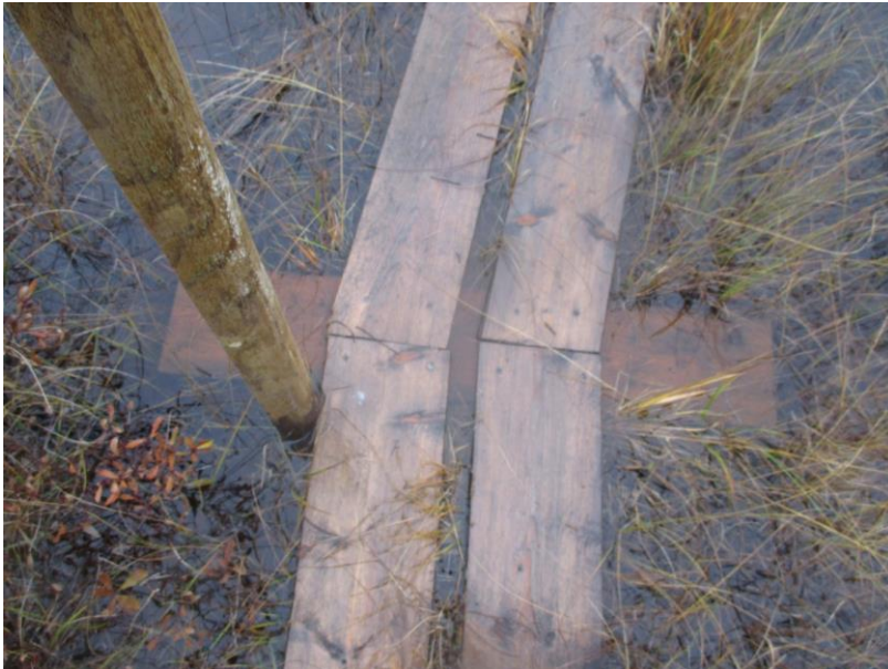
Fig 3. Forankring av gangbanene for å hindre forflytning ved oversvømmelse, samtidig som gangbanene flyter i takt med vannstanden.
