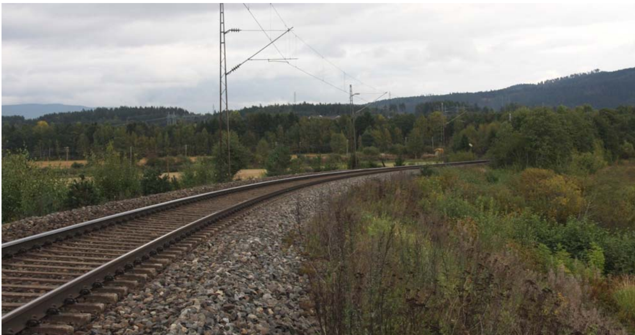
Figur 10. Mange benytter jernbanelinja som adkomst til fugletårnet fordi stien er svært bløt. Dette er livsfarlig, og er en viktig grunn til at planen prioriterer kloppet sti til fugletårnet. Reservatet på høyre side av jernbanesporet. Foto: Kjetil Heitmann.
