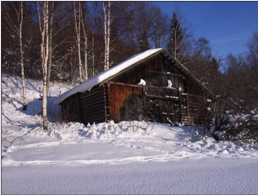
Figur 23. Laftet låve i ytterkanten av verneområdet. Denne bygningen er i relativt god stand.
