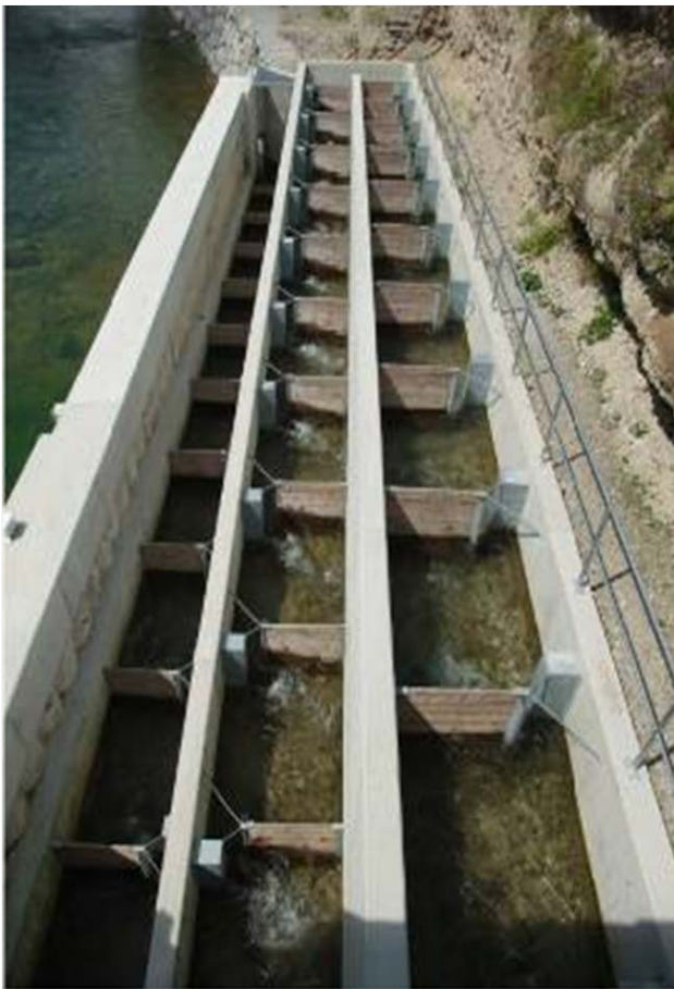
Abb. 5.5: Schlitzpass (am Beispiel Ybbs)
