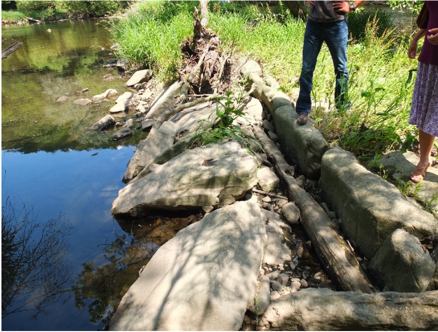
Abb. 6.2: Wehr Podmolí I (Devět mlýnů, Fkm. 142,734) - Aufbau des Wehrs als Setzsteinrampe mit querliegenden Holzbalken in der Krone (Foto: Froschauer)
