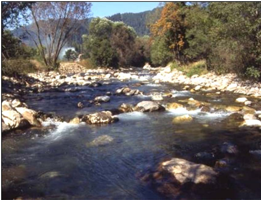
Abb. 5.2: Rampe auf gesamter Gewässerbreite (am Beispiel Pöls)
