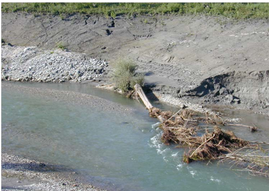
Abb. 7.6: Raubaum mit Stahlseilen gesichert
