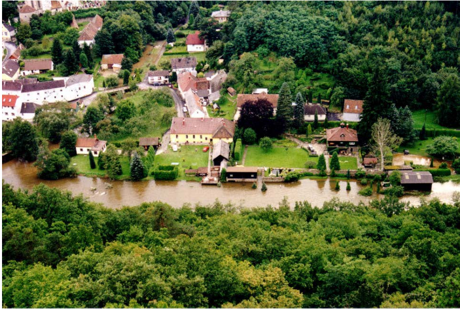
Abb. 6.4: Überflutung bei Hochwasser 2002 im Bereich Mündung Fugnitz flussauf der Wehr Hardegg II (Foto: Nationalpark)
