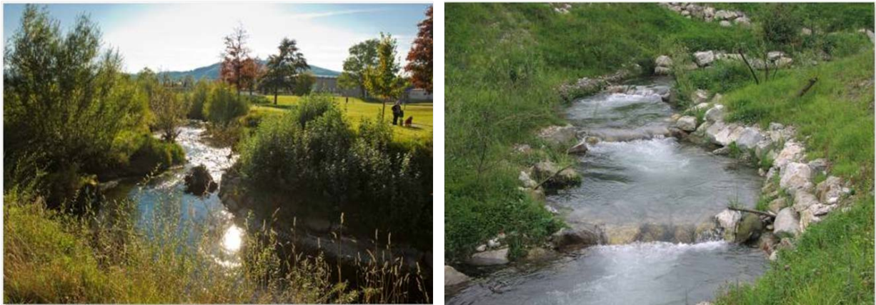
Abb. 5.6: Gewässertypisches Umgehungsgerinne (links) und Naturnaher Beckenpass (rechts) (beide am Beispiel Traisen)
