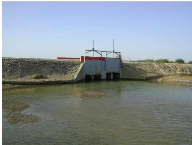
Figure 4 : Pont de Bount-Batt avec vannes (photo, D. Diouck, 2010)
