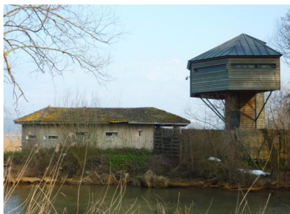
Illustration 22. Vue sur l'observatoire du lac et le gabion observatoire, tous deux à vocation pédagogique
