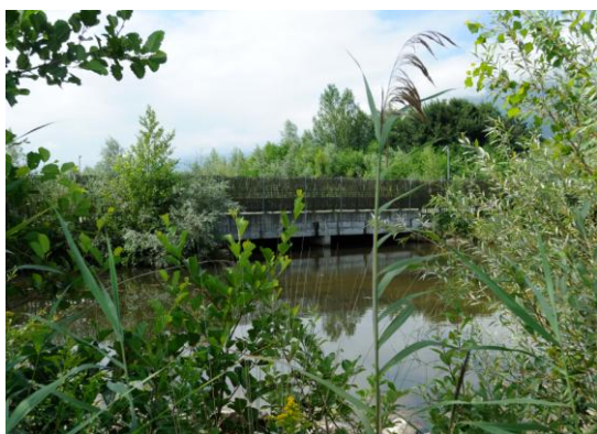
Illustration 2. Dalot du canal écrêteur des crues de la Leysse situé sur le domaine de Buttet
