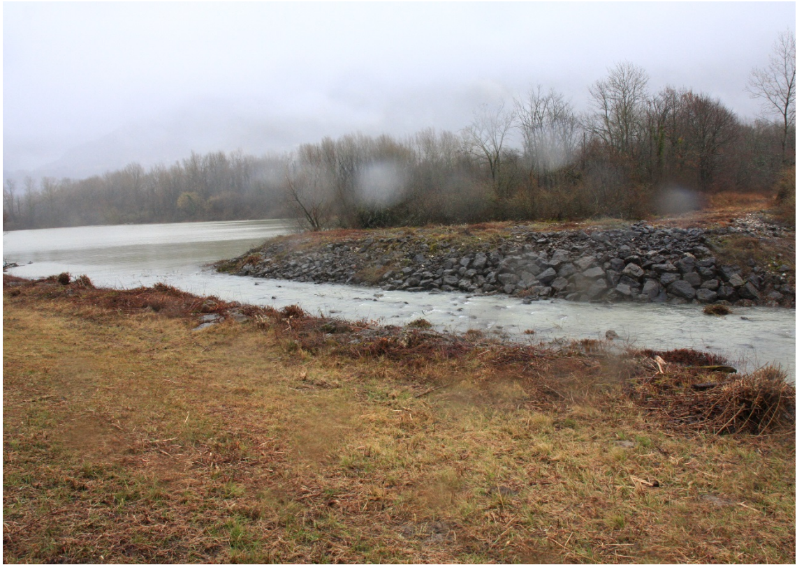
Déversoir inter-casier en période de crue (photo C. Morat CNR).
