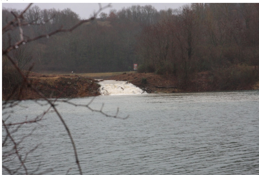
Déversoir du Rhône : entrée dans le casier amont (photo C. Morat CNR).
