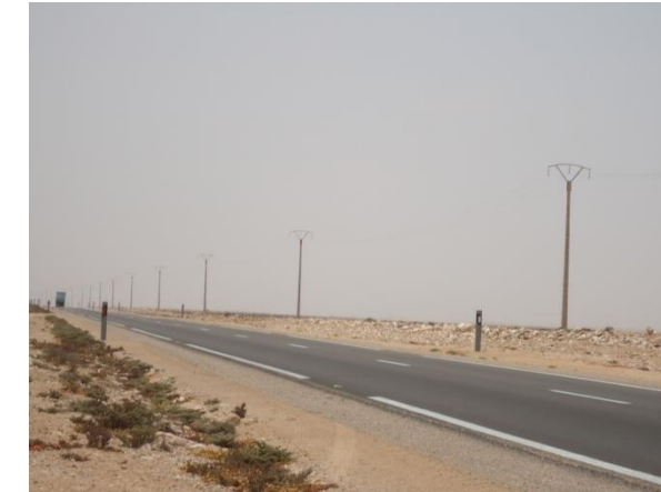
Figure 34 : Vue sur la ligne BT
