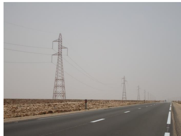
Figure 32 : Vue sur la ligne 225 KV
