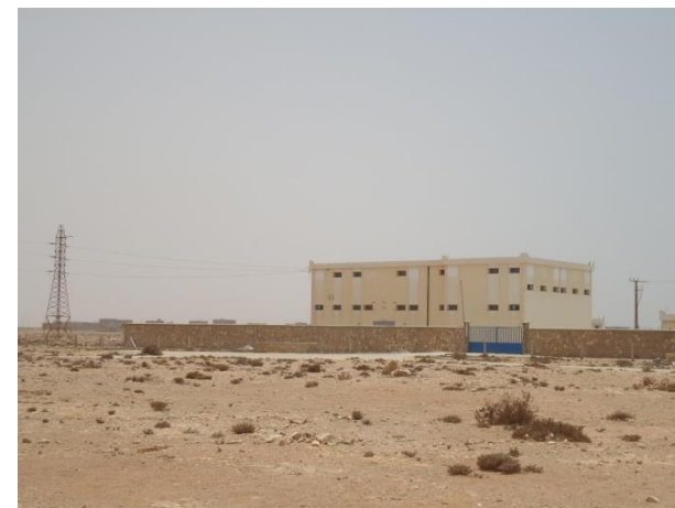
Figure 33 : Vue sur le poste de l'ONEE
