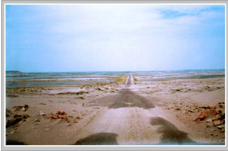
Foto 5: Represamiento del Agua por Efecto de la Carretera
