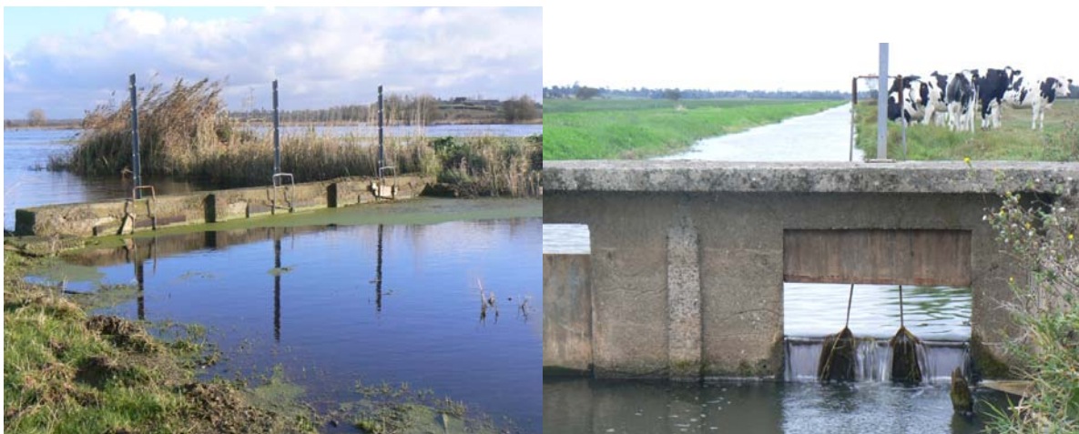
Photo 5 et 6 –Vannage 2 aval de la Rivière Neuve et la Taute – Rehausse de quarante centimètres d’une des 3 vannes - Source- S. Marie - FDCM
