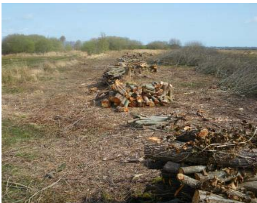
Photo 24 - Secteur central - Travaux de déboisement – avril 2010
