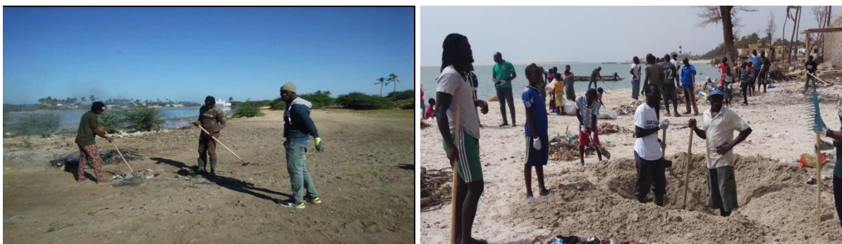
Photos 6 : assainissement des berges des lagunes et fleuve
