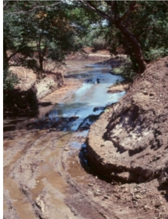
Foto. El dragado del cauce del Río Palmas tuvo un fuerte impacto ambiental. J. Jiménez 2000.
