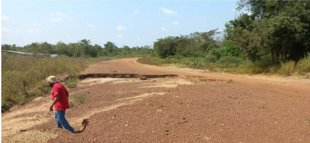
Figure 29. Erosion de la nouvelle route, un indicateur de l'intensité des pluies et donc du risque d'une disparition rapide des sédiments des berges en l'absence de couvert végétal.
