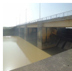
Vanne pour évacuation du trop plein d'eau du barrage ( Aboubakar OUATTARA, 09-12-2016 )
