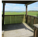
Bird watching tower ( Länsstyrelsen i Västra Götaland, 15-06-2011 )
